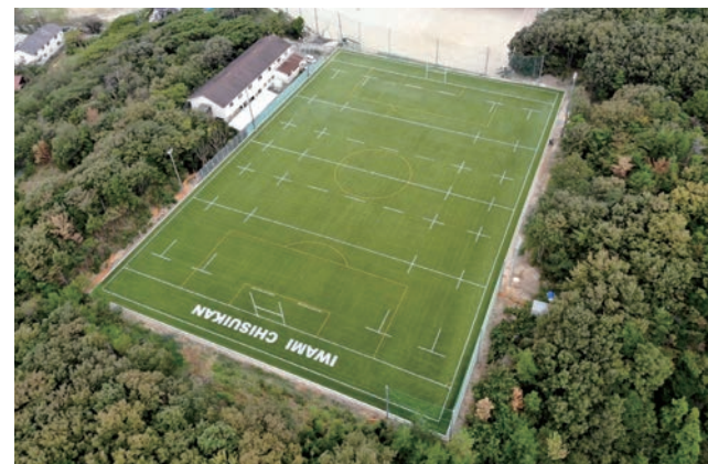
石見智翠館高校 ラグビー場人工芝設置工事
