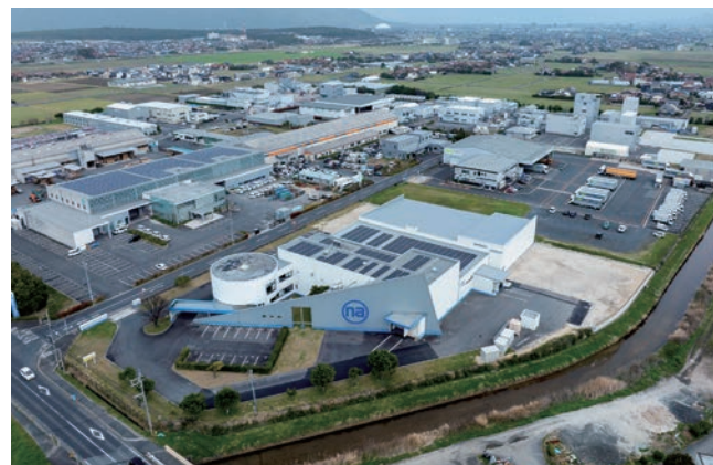
(株)西口アンプル製作所 出雲工場第3棟増築工事
