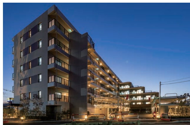
プレシス戸田レジデンス 新築工事
