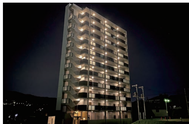
レジスタ大塚西 新築工事
