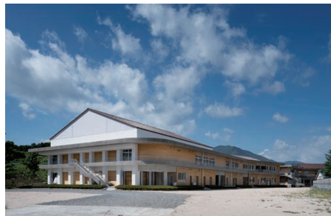
邑南町立石見中学校 改築工事
