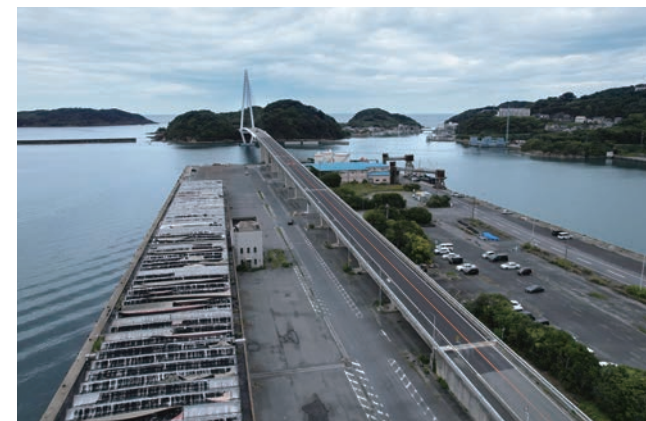
島根地区(浜田漁港) 浜田マリン大橋(舗装修繕)工事
