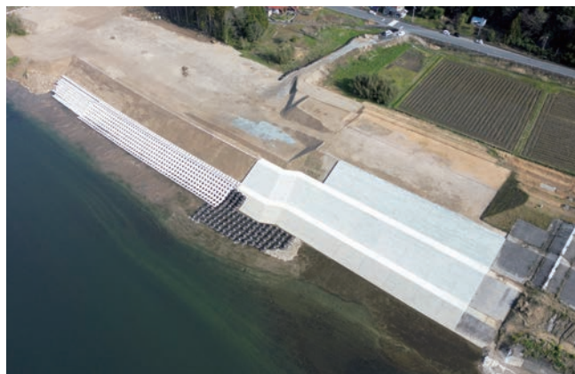
令和5年度 江の川大貫地区外築堤護岸工事
