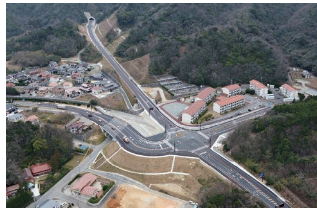
浅利渡津線(渡津工区) 総合交付金(改築)舗装工事
