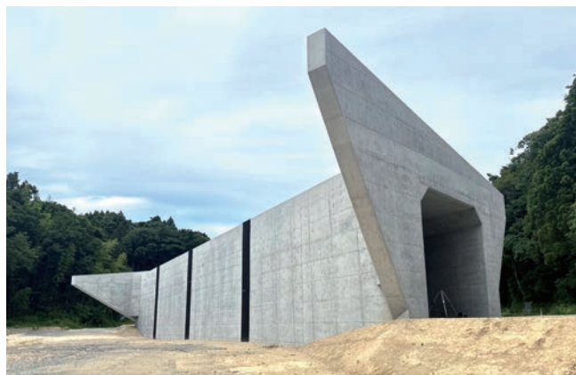
令和4年度 福光・浅利道路黒松西地区第2改良工事
